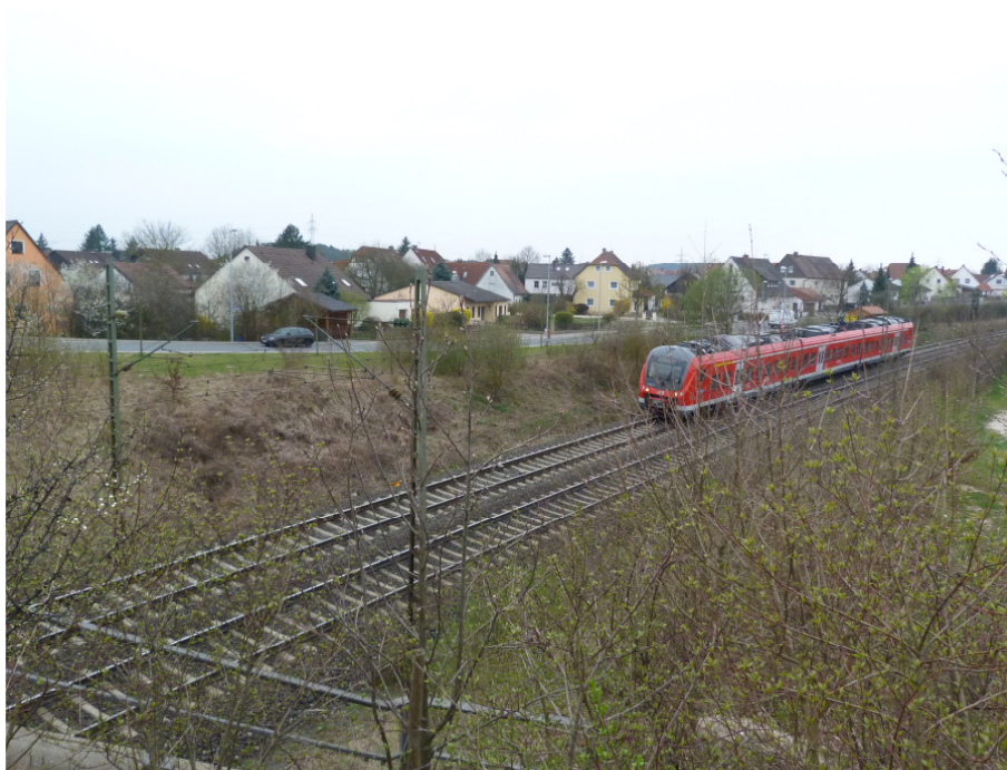
Blick von der Bahnüberführung in Richtung Westen
